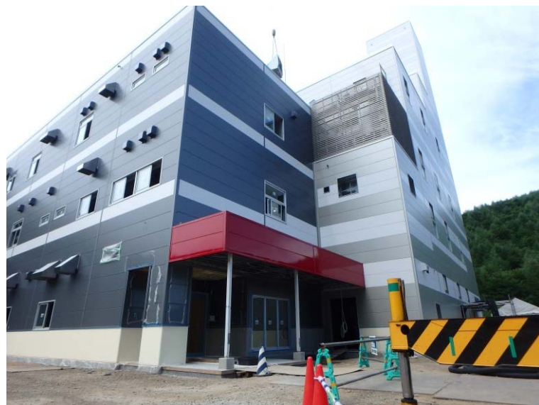
7/27 正面玄関（北側）
