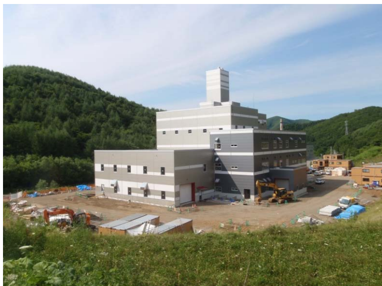
7/31 全景（南側より）
