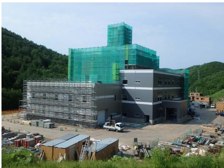
6/30 全景（南側より）
