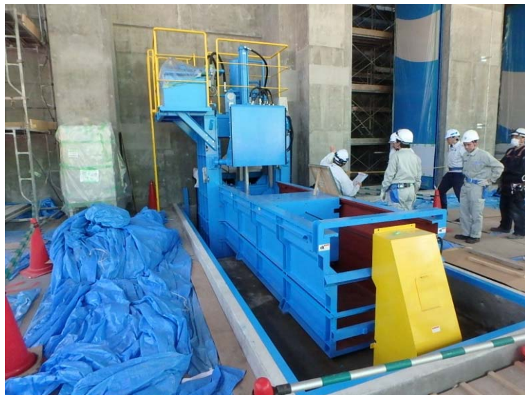
6/6 粗大ごみ破碎機据付状況
