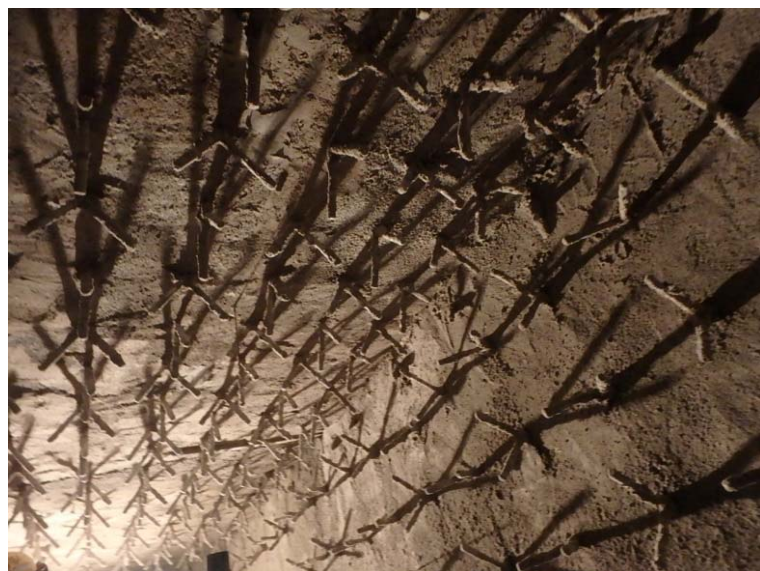
6/6 断熱キャスト施工状況
