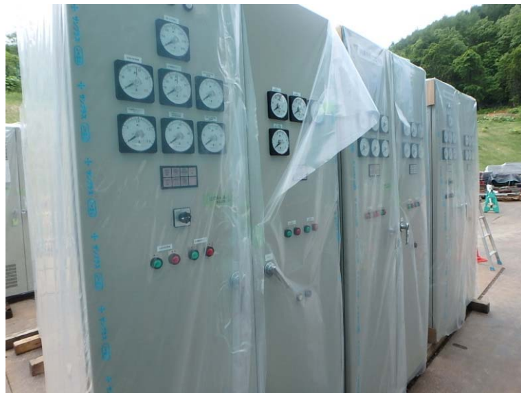
6/5 電気室制御盤搬入状況
