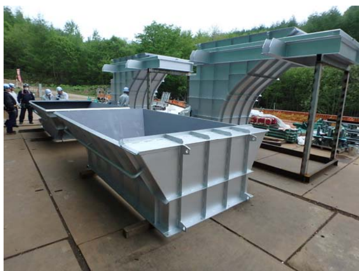
5/25 ごみ投入ホッパー搬入状況
