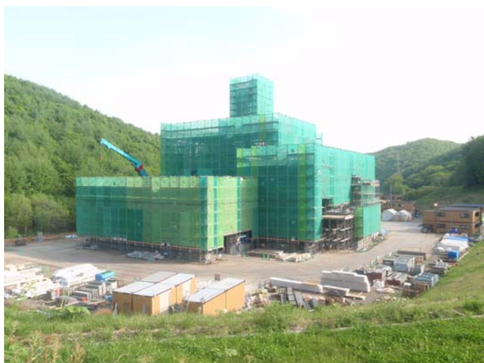
5/31 全景（南側より）
