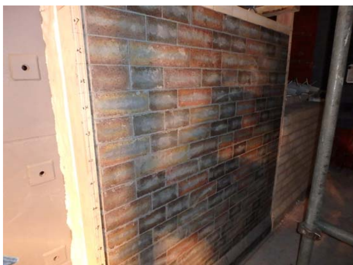
5/23 炉内耐火煉瓦施工状況
