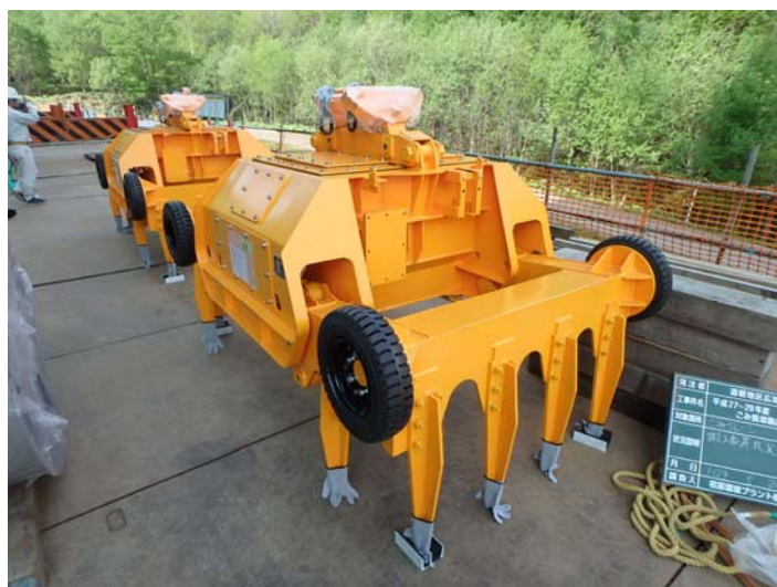
5/20 ゴミクレーン搬入状況
