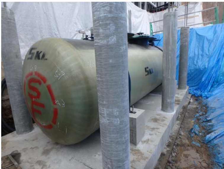
3/1 地下タンク据付状況
