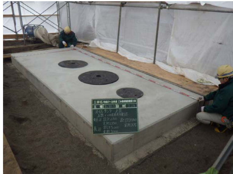
3/24 地下タンク上部スラブ施工状況
