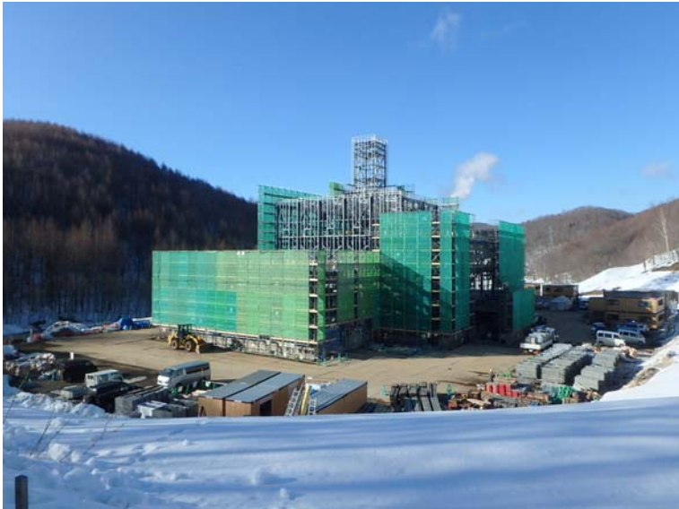
3/31 全景 (南側より)
