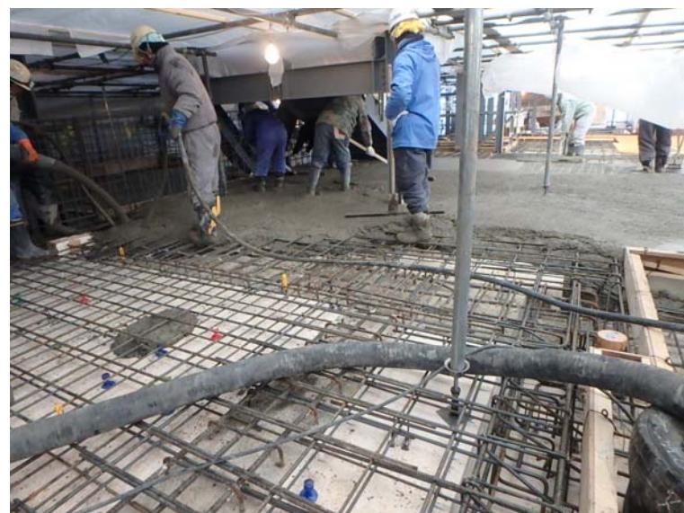
2/2 管理棟床打設状況
