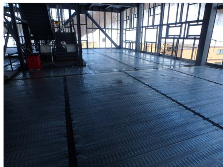
2/27 管理棟2階 デッキプレート施工状況
