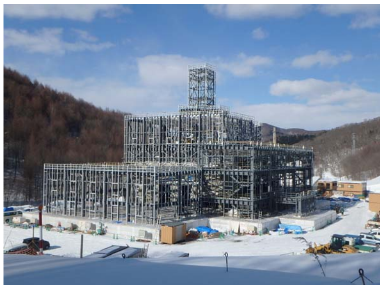
2/27 全景（南側より）
