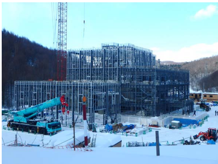
1/31 全景 (南側より)
