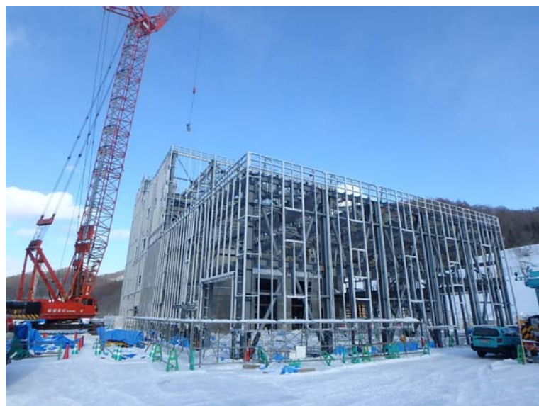
1/31 プラットホーム外観 (南西側より)
