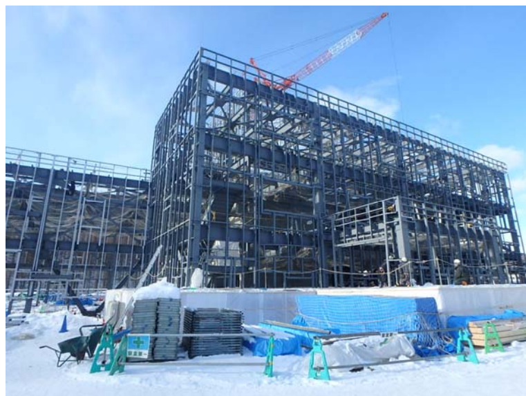
1/31 管理棟計量室外観 (東側より)
