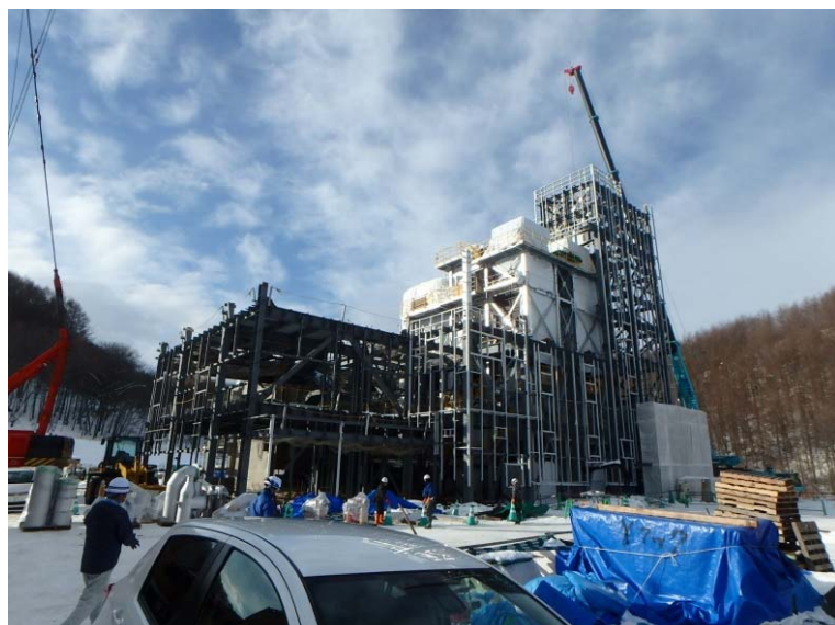
12/20 灰処理室鉄骨建て方 (北東側より)
