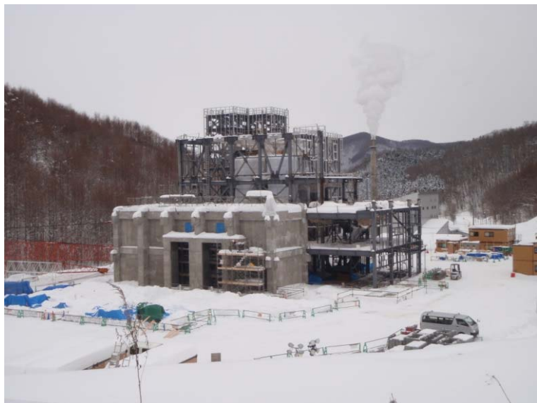
12/29 全景 (南側より)
