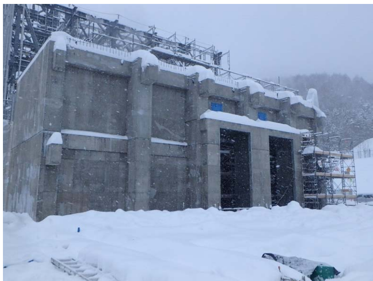
12/24 ごみピット外観 (足場解体状況)
