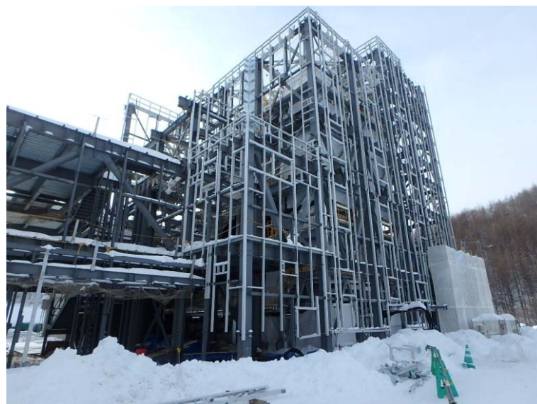
12/26 炉室鉄骨建て方 (北東側より)
