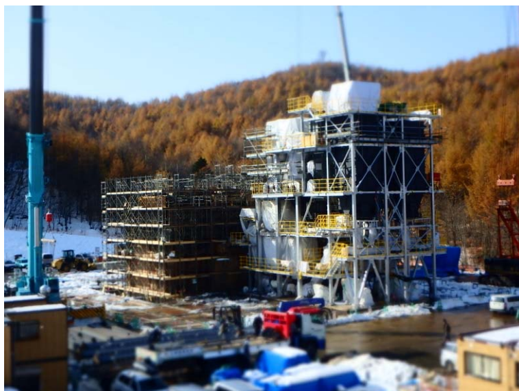
11/14 バグフィルター設置状況 (北東側より)
