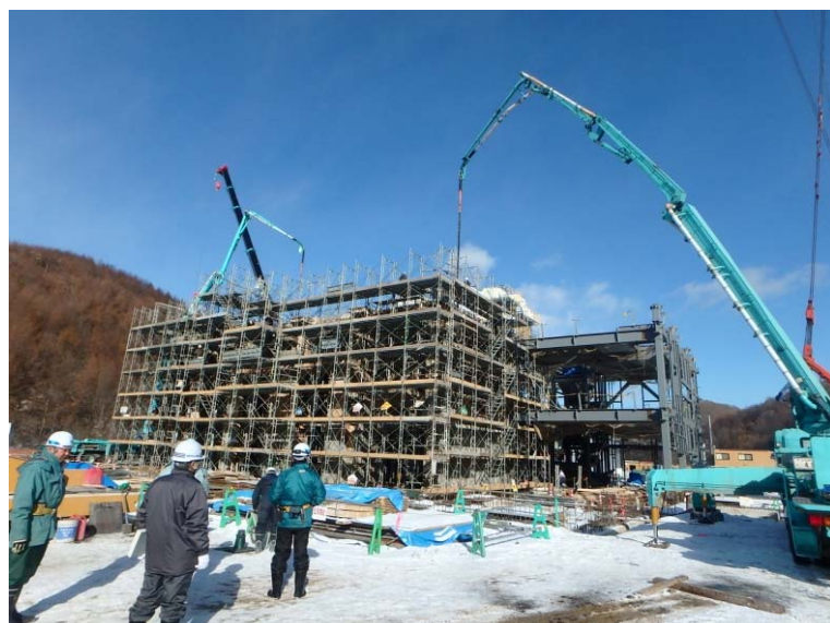
11/24 ごみピットコンクリート 打設状況 (FL+10,000) (南側より)
