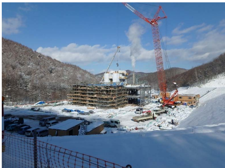
11/30 全景 (南側より)
