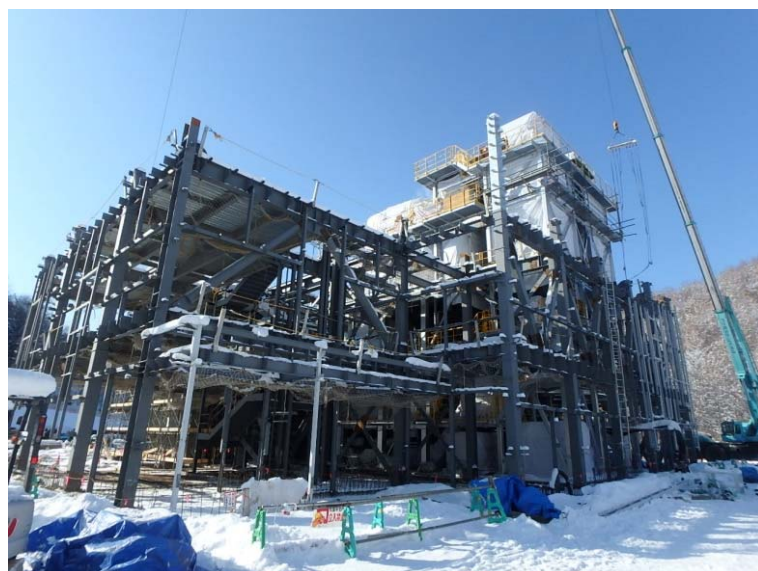
11/30 管理棟2階鉄骨部 (北東側より)
