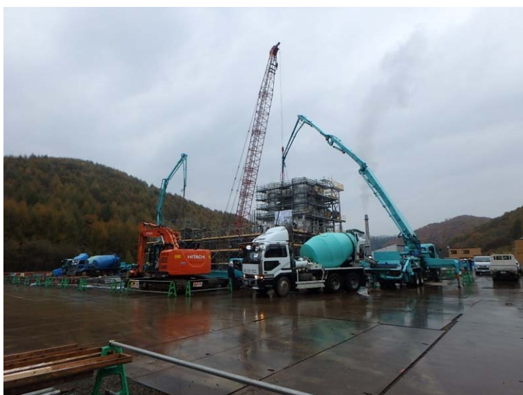
10/25 ごみピットコンクリート 打設状況 (FL+5,000) (南側より)
