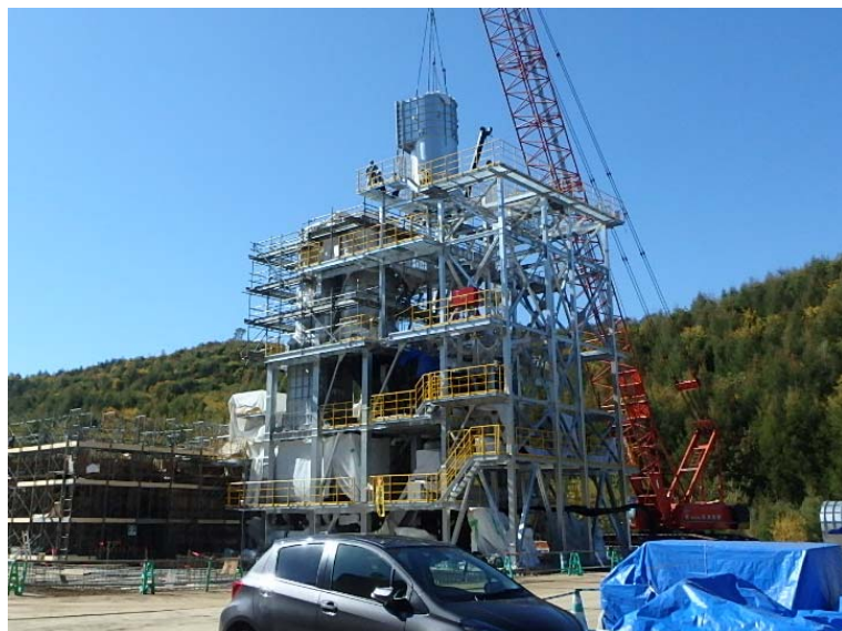
10/18 排ガス冷却塔据付状況 (北東側より)
