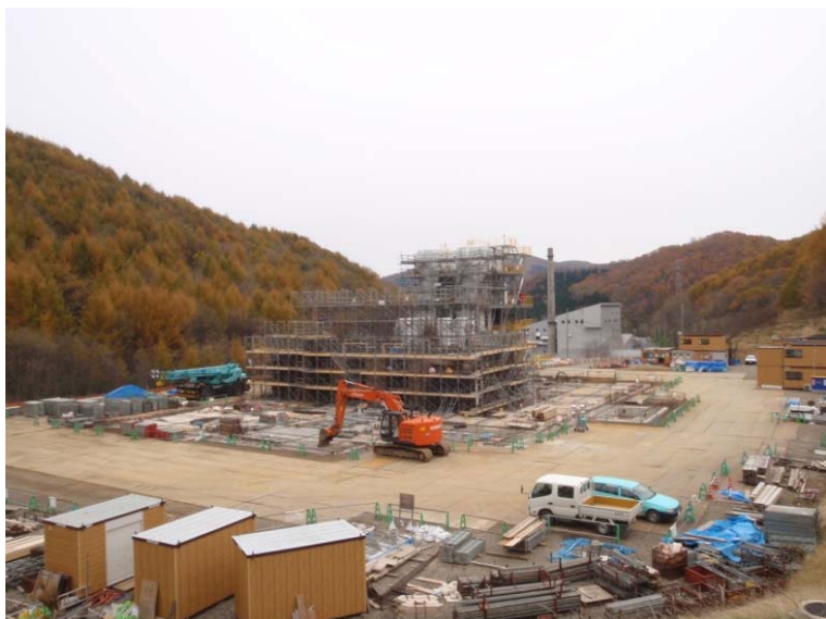
10/31 全景 (南側より)
