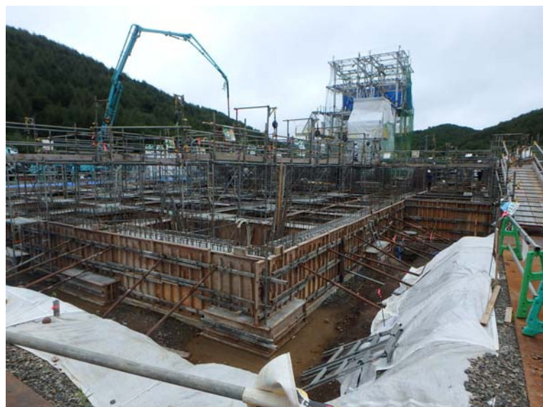
9/10 管理棟基礎コンクリート打設業況 （南東側より）
