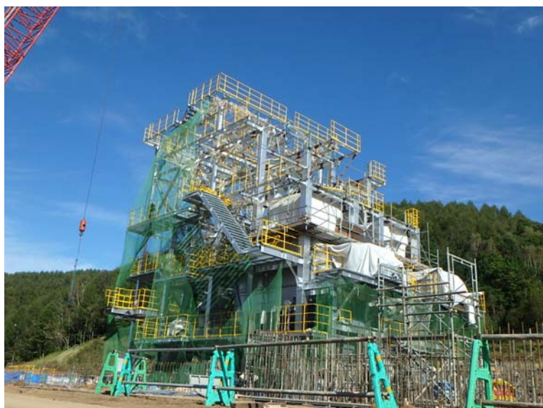
9/30 炉架構・炉本体設置状況 （南西側より）
