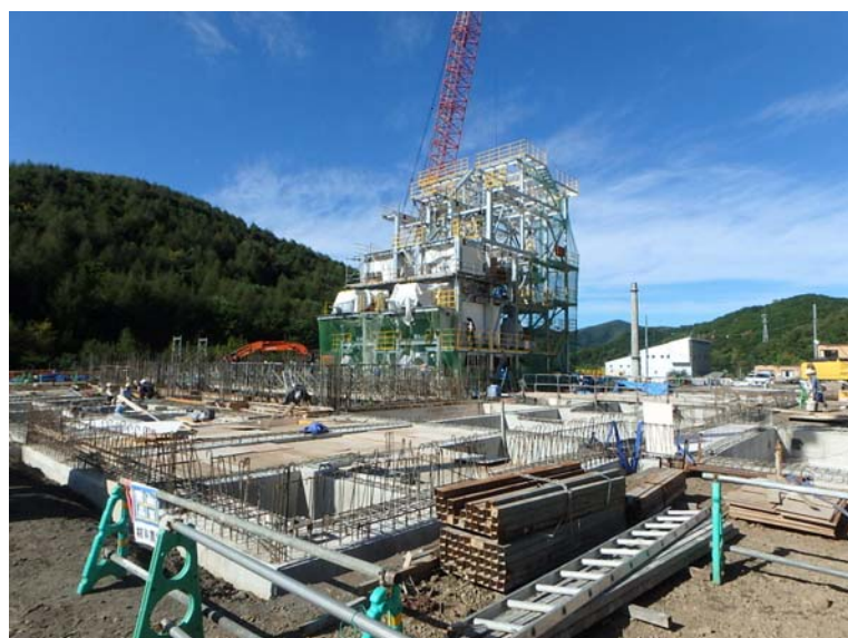
9/30 プラットホーム・管理棟基礎埋戻し状況 （南東側より）
