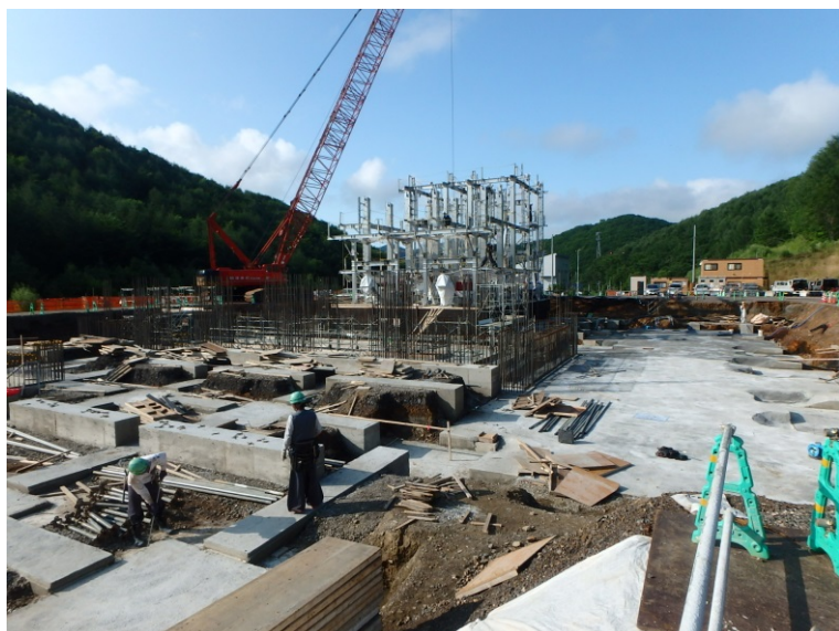
8/5 プラットホーム・管理棟基礎配筋前 （南東側より）
