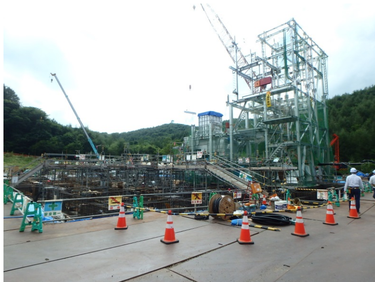
8/25 炉架構設置状況（北東側より）
