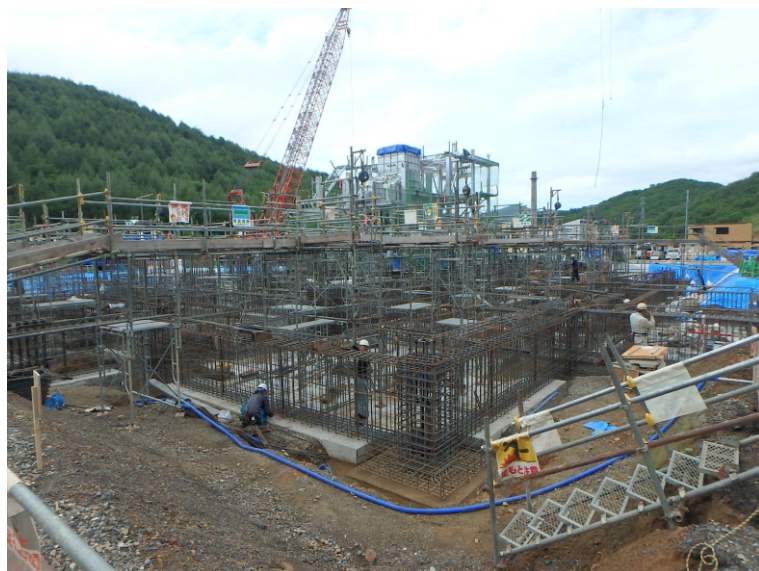
8/19 プラットホーム・管理棟基礎配筋状況 （南東側より）
