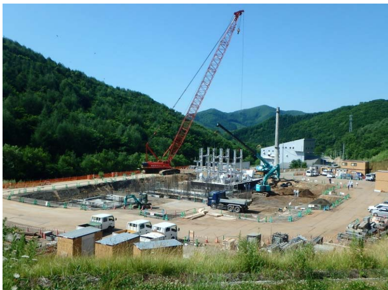
7/25 全景（南側より）
