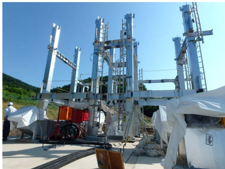
7/25 炉室炉架構据付状況
