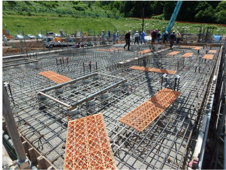
6/15 炉室耐圧版コンクリート打設状況
