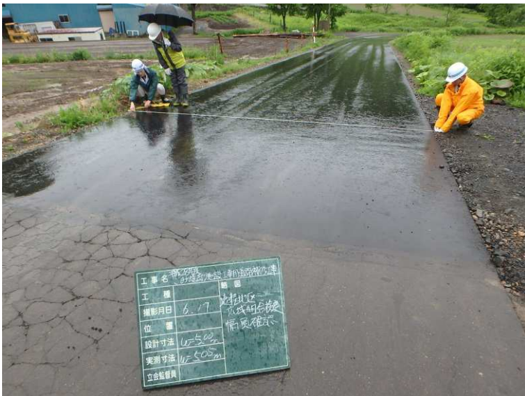
6/17 工事用道路補修工事完成
