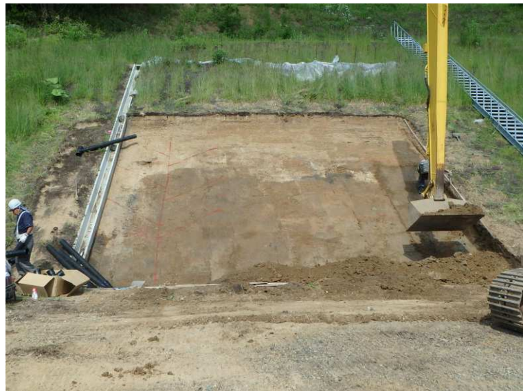
6/24 建設用地法面改修工事掘削状況
