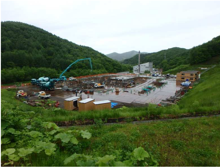
6/18 全景（南側より）
