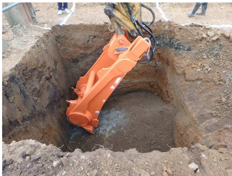
地盤改良状況
