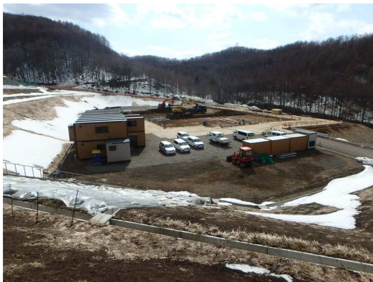
掘削状況（北側より）
