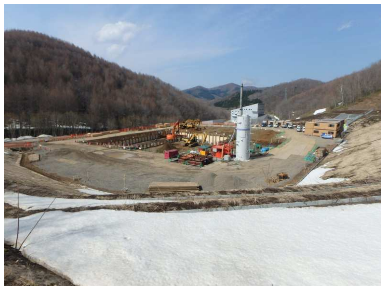
地盤改良状況（南側より）
