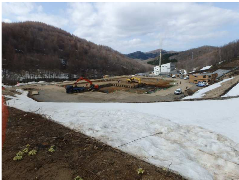
掘削状況（南側より）
